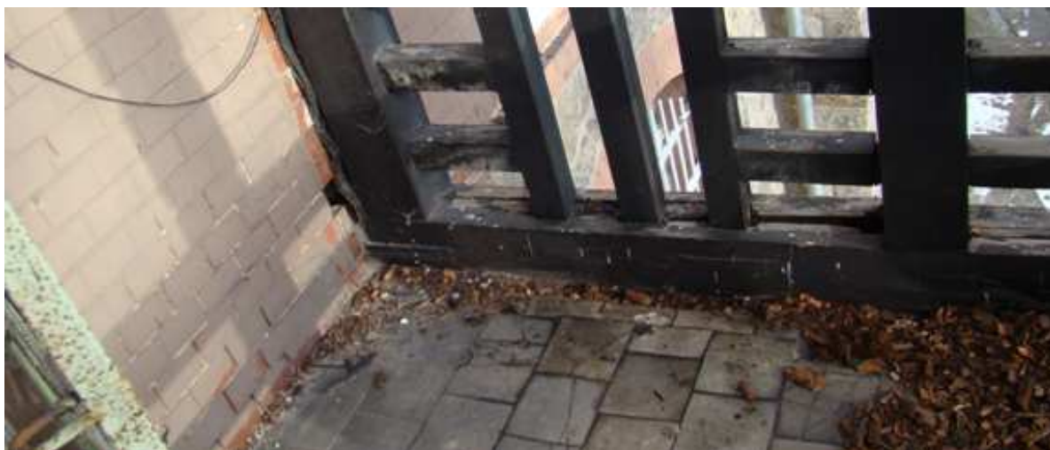
uszkodzona podwalina tarasu południowego – widoczne zakotwienie w ścianie
