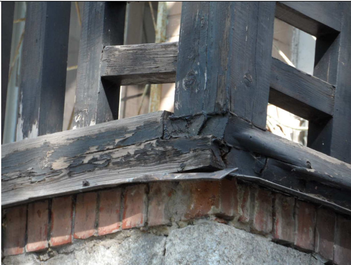
stan elementów konstrukcyjnych balkonu południowego
