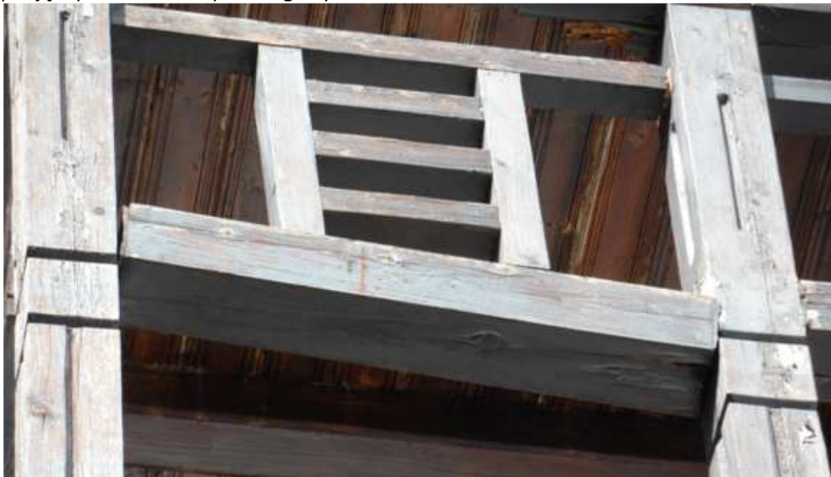
uszkodzone ozdobne elementy tarasu południowego
