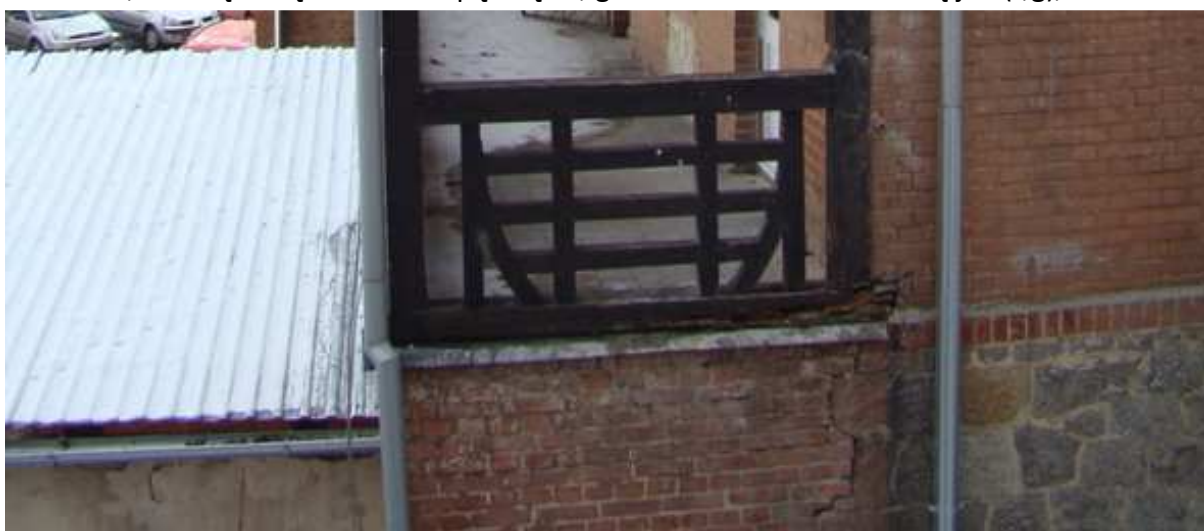
spękana ściana pod balkonem wschodnim
