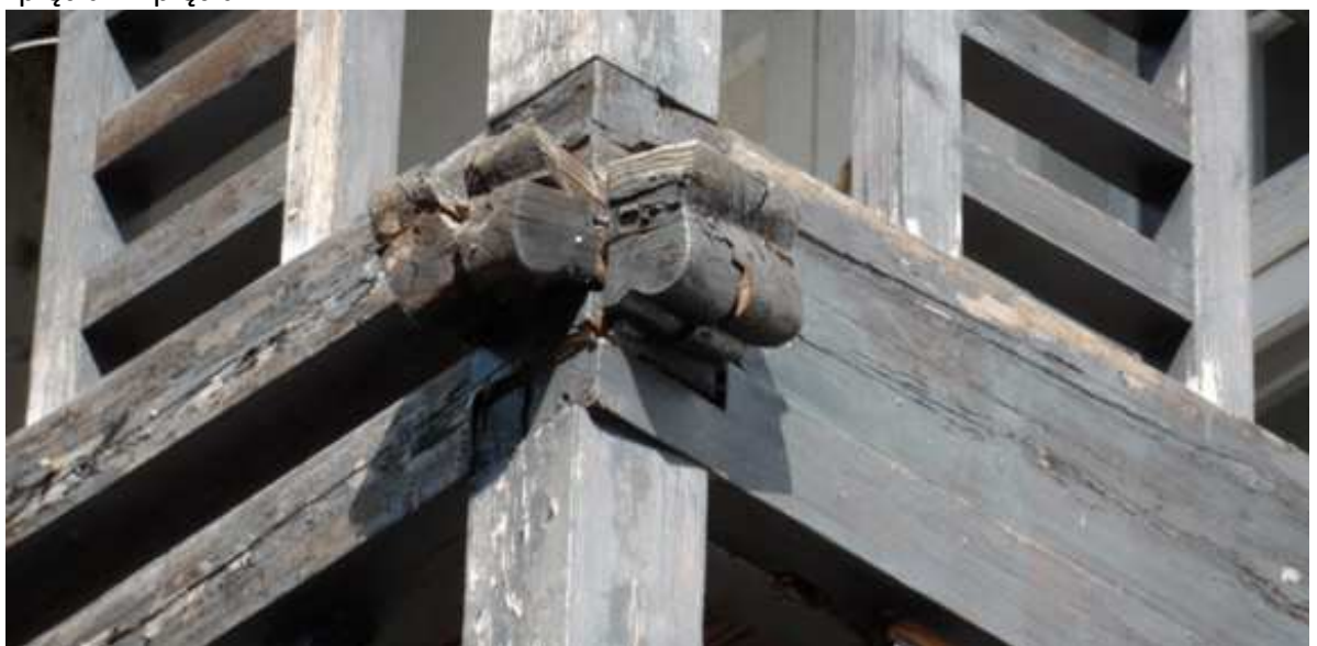
belki oczepowe i podwalinowe tarasu południowego wraz z „ostatkami” belek stropowych
