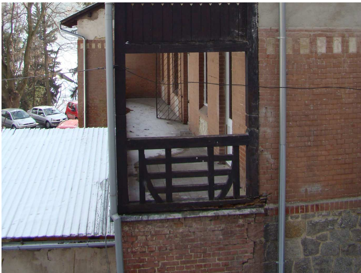
spękana ściana pod balkonem wschodnim
